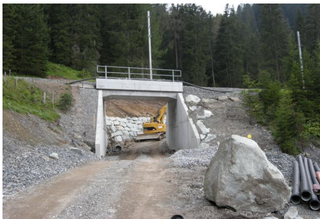
Bodenplatte vor dem Betonieren
