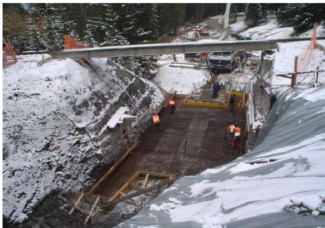
Bodenplatte vor dem Betonieren
