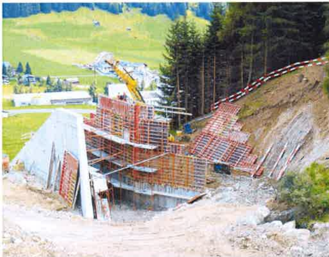
Das gegenwärtig im Bau befindliche Auslaufbauwerk am Bildjibach. Daneben der nach gleichem Muster gebaute und vor einem Jahr fertiggestellte Geschiebesammler am Dorfbach.
