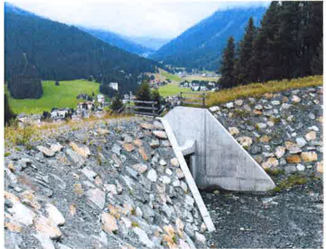
Das gegenwärtig im Bau befindliche Auslaufbauwerk am Bildjibach. Daneben der nach gleichem Muster gebaute und vor einem Jahr fertiggestellte Geschiebesammler am Dorfbach.
