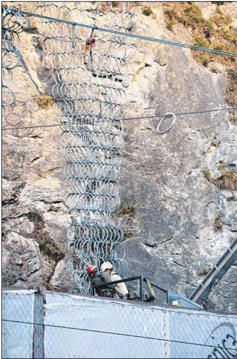
Zentimeter für Zentimeter ziehen die Arbeiter von der Hebebühne aus das massive Steinschlagschutznetz in Position.
