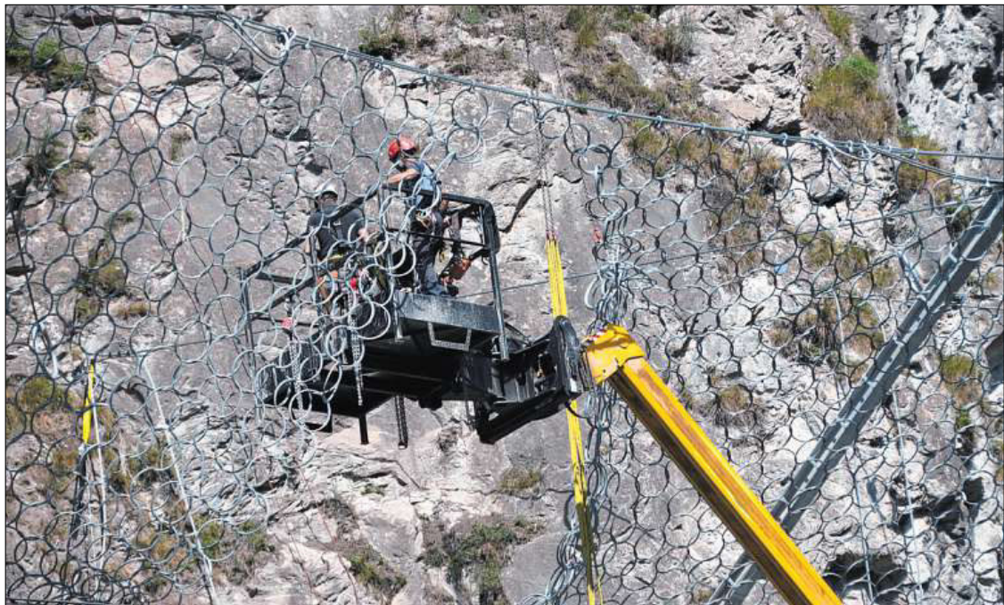
Ein nicht alltäglicher Arbeitsplatz: Das massive Steinschlagschutznetz wird montiert.
