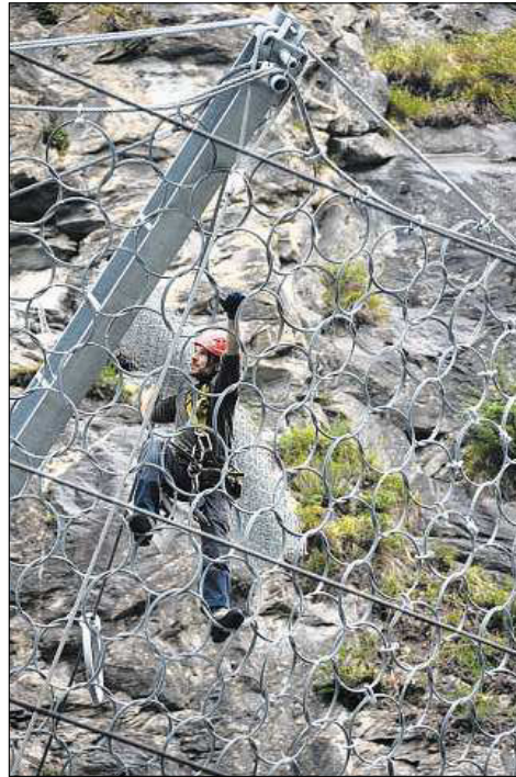
Schwindelfrei zu sein, ist nur eine der Herausforderungen beim Anbringen des feinen Drahtnetzes zum Schutz von Strasse und Bahn.
